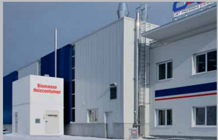
Doppelstock-Hackgut-Heizcontainer neben einem Firmengebäude.
