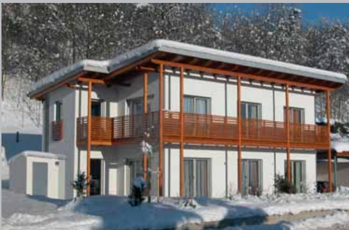
Einstock-Heizcontainer direkt an der Wohnhausanlage.
